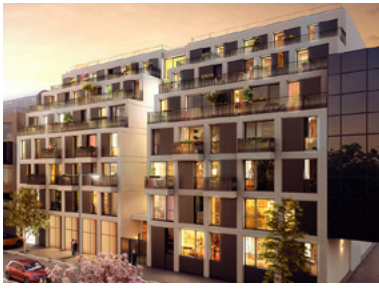
ISSY-LES-MOULINEAUX - Carré Peupliers Co-promoteur : COGEDIM Architecte : Agence d'architecture PPX
